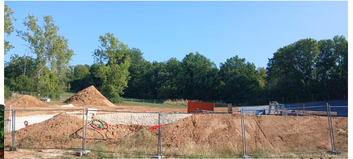
Les travaux en cours à Salviac
