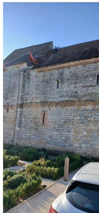
Réparation du toit de l'église de Florimont le 19 septembre par l'entreprise Beausse. Les tuiles avaient été déplacées lors d'un coup de vent ...
