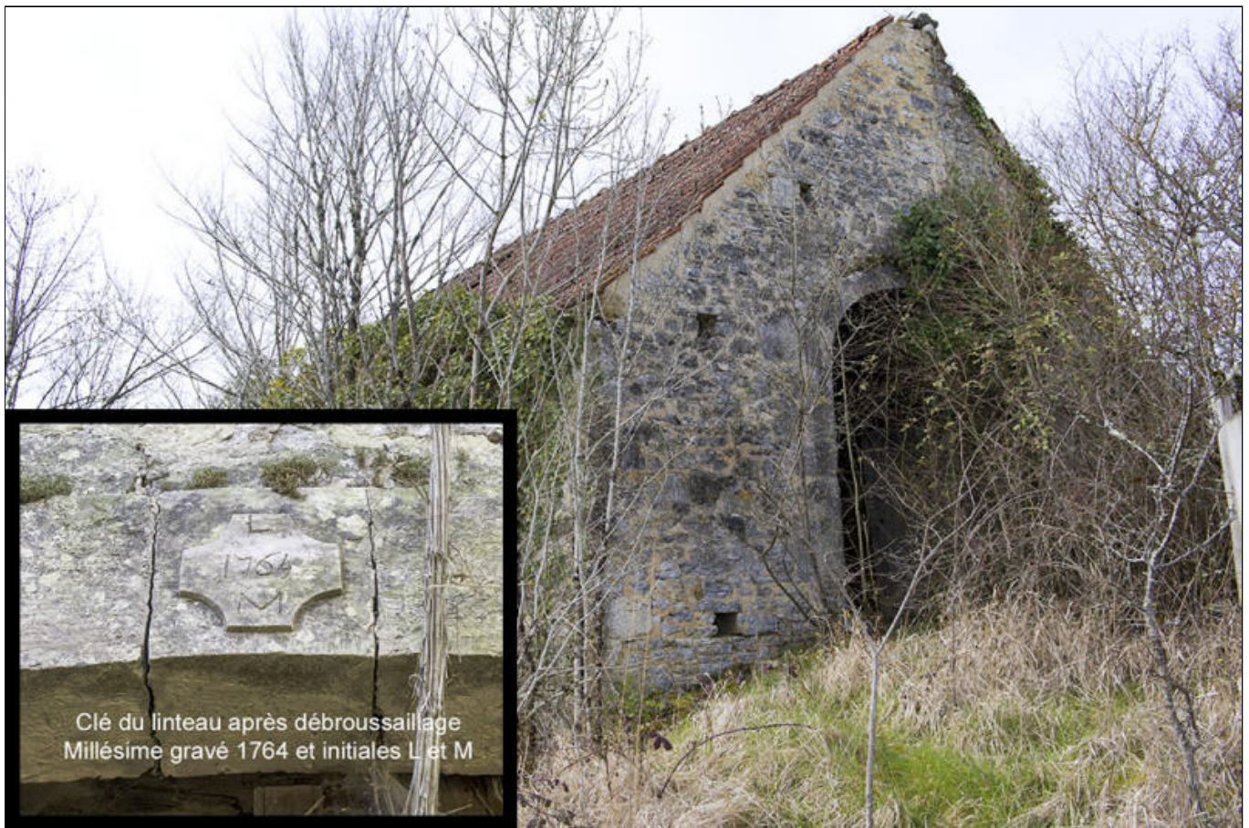
Fig. 35 - Grange N° 2 : pignon Nord.
