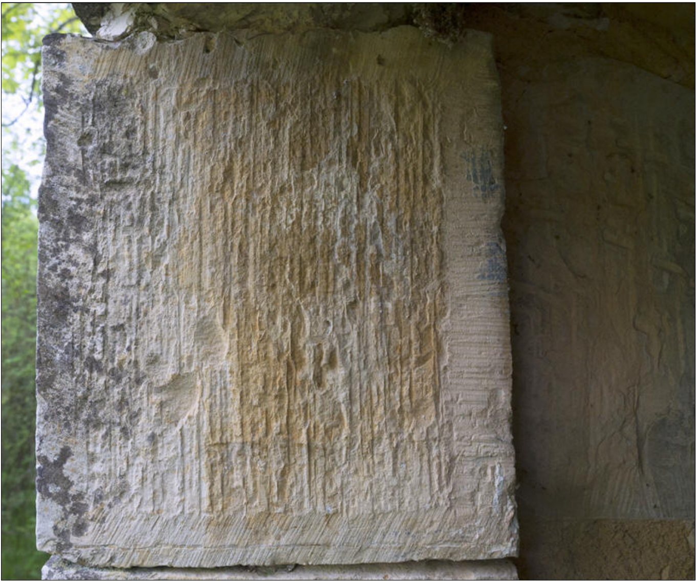
Fig. 44 - Le pigeonnier : la taille d'un angle de l'entrée Ouest.
