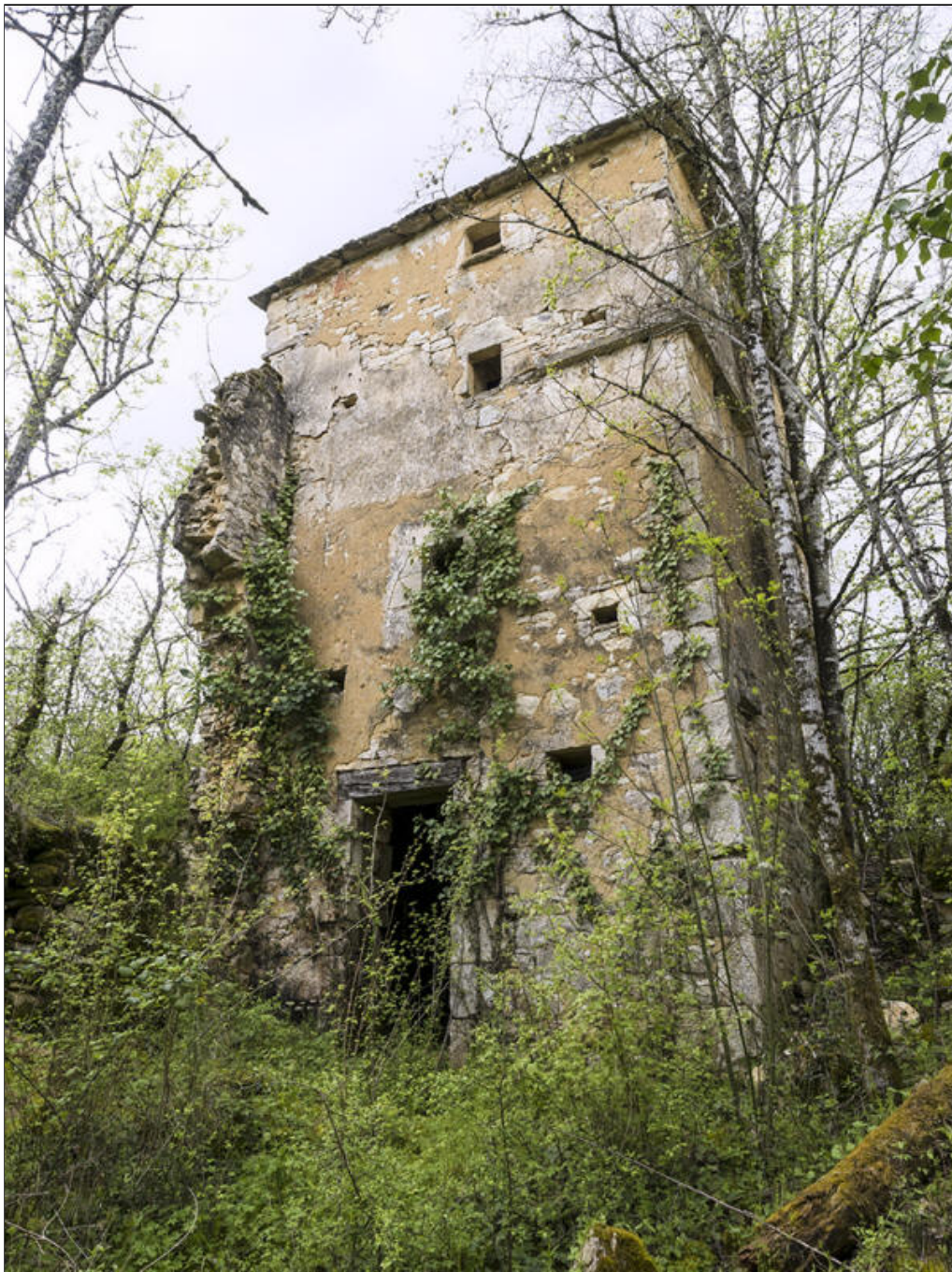
Fig. 40 - Le pigeonnier : façade Est.
