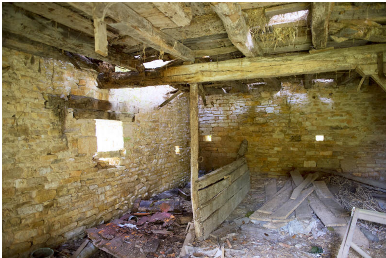
Fig. 26 - Grange N° 1 : le pignon Est et son « fenestrou » à partir de la seconde entrée de la façade.
