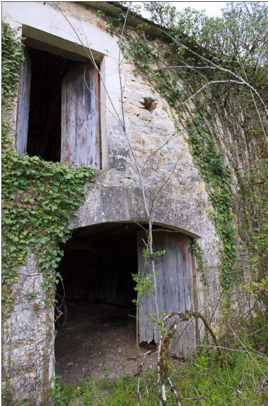
Fig. 34 - Grange N° 2 : vue rapprochée de la porte et de la fenêtre centrales de la façade.
