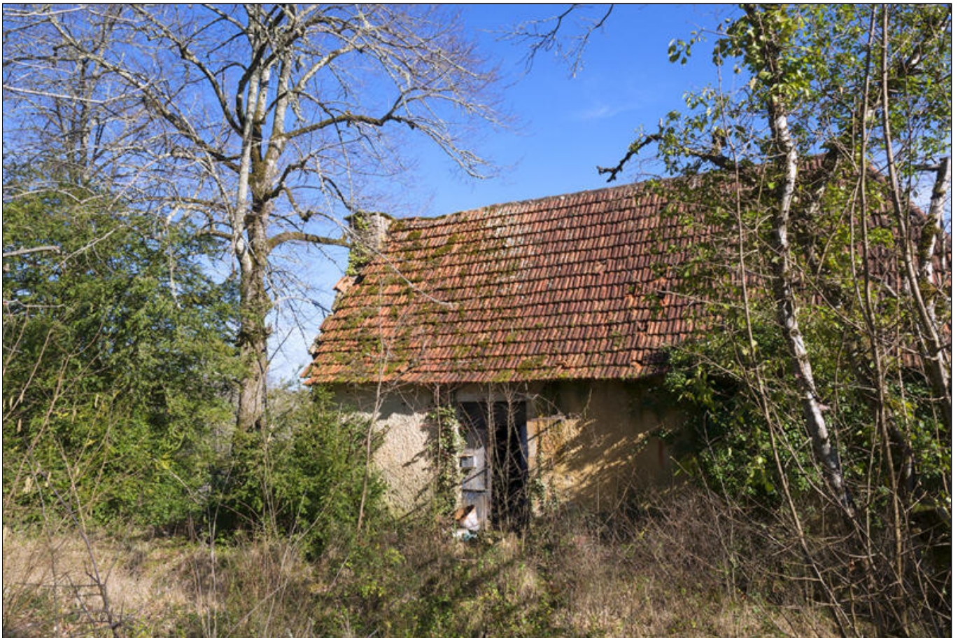
Fig. 10 - La maison : façade Ouest.
