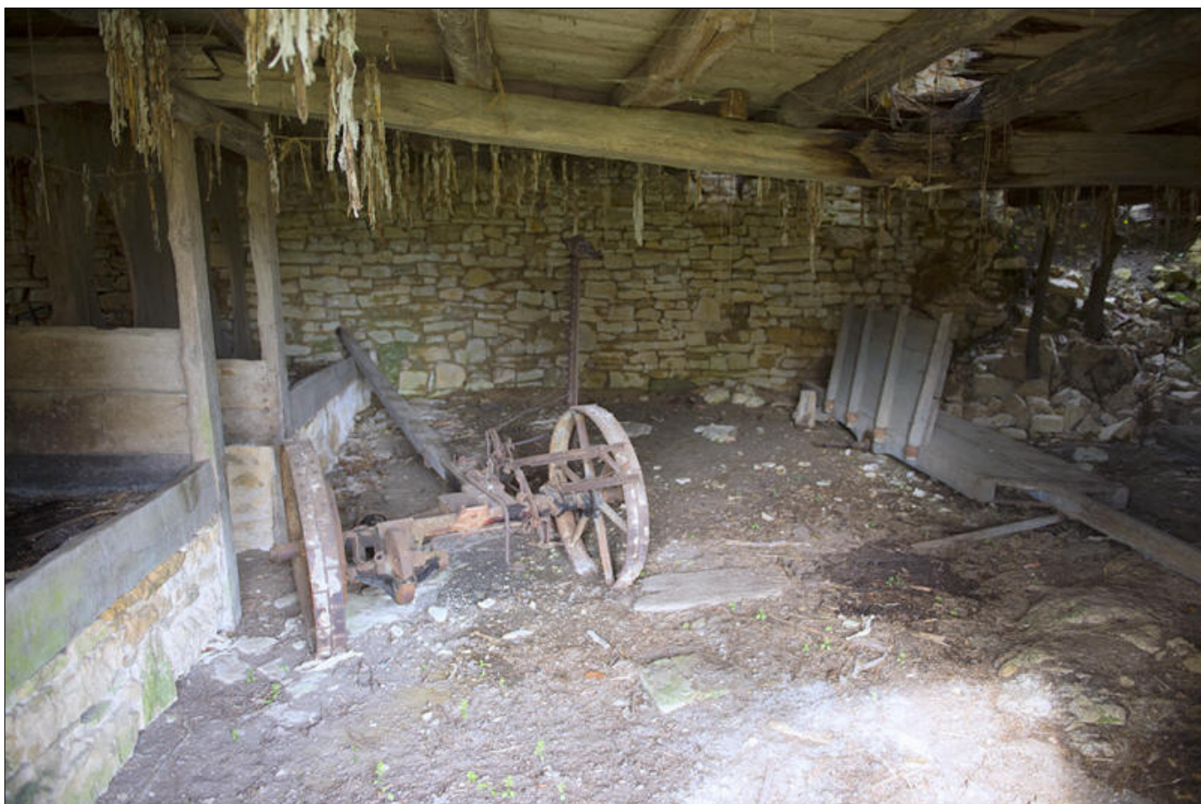
Fig. 38 - Grange N° 2 : la travée centrale, où la poutre, en très mauvais état, menace de rompre.
