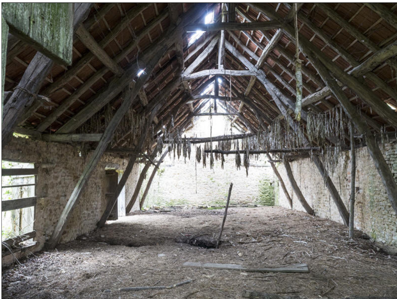
Fig. 39 - Grange N° 2 : l'étage et la charpente.
