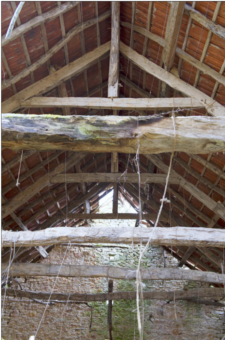
Fig. 30 - Grange N° 1 : la charpente de l'étage.
