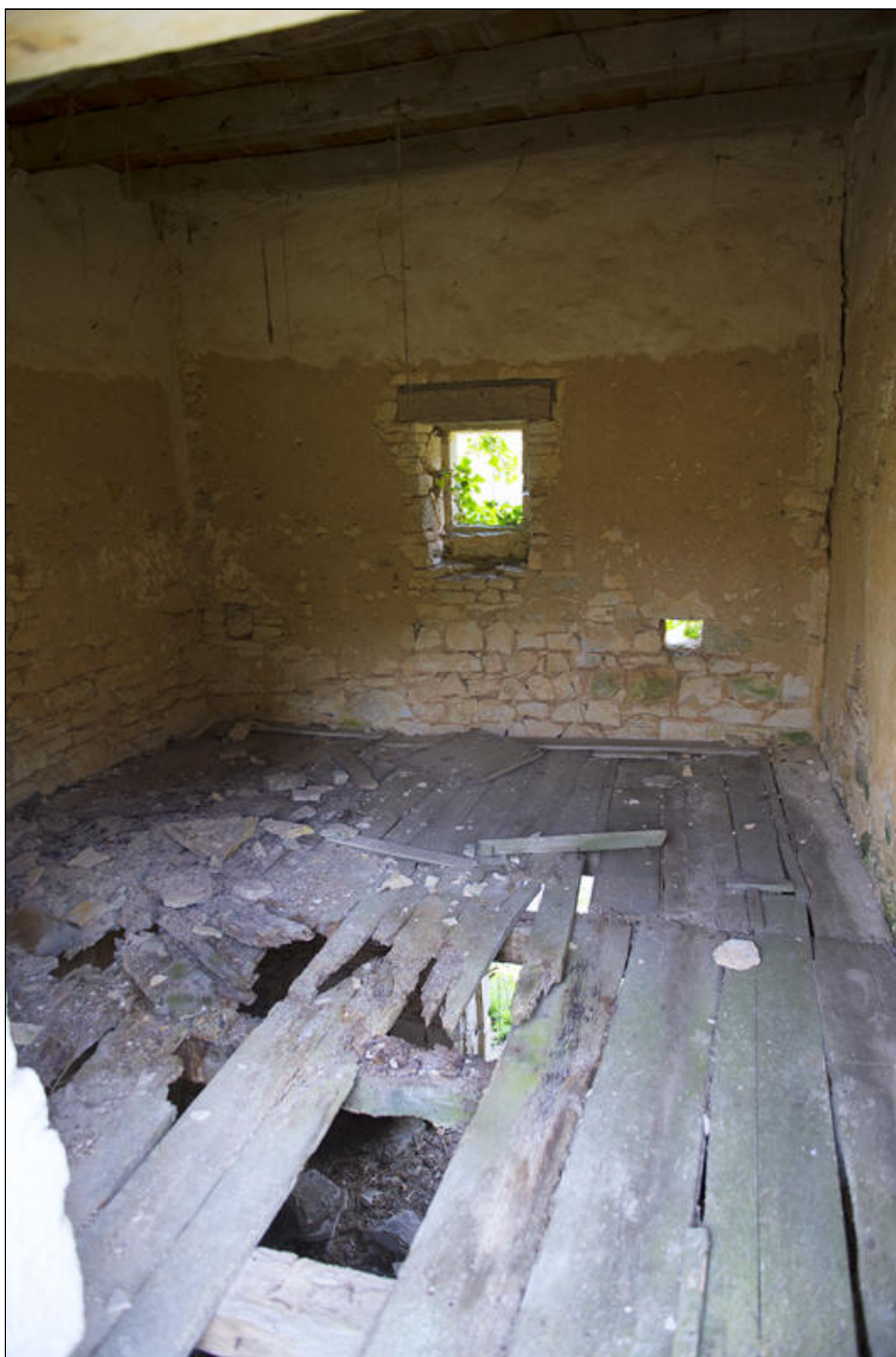
Fig. 49 - Le pigeonnier : premier étage ; les murs sont bâtis à la terre et enduits d'un mortier à la chaux.
