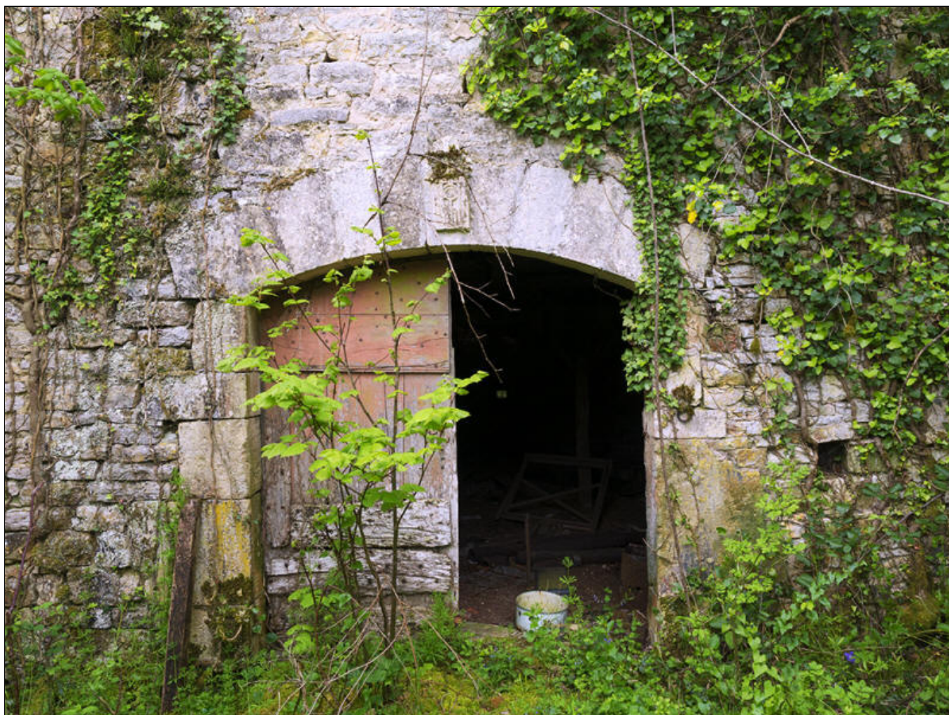
Fig. 22 - Grange N° 1 : la seconde entrée, en arc surbaissé, du gouttereau Nord.
