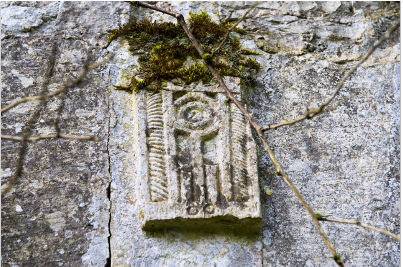
Fig. 24 - Grange N° 1 : clé sculptée de l'arc de la seconde entrée du gouttereau Nord. Le motif semble être une clé de serrure !
