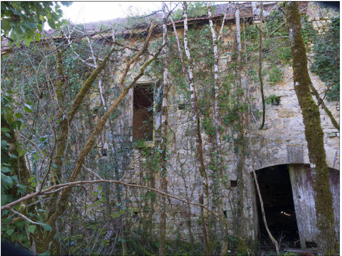
Fig. 21 - Grange N° 1 : partie de la façade Nord.
