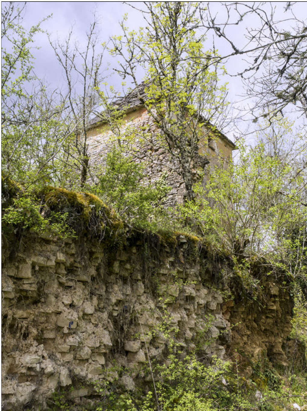
Fig. 42 - Le pigeonnier : vue vers le mur Sud ; au premier plan, le long du passage d'accès, le mur a vu ses pierres de parement arrachées..
