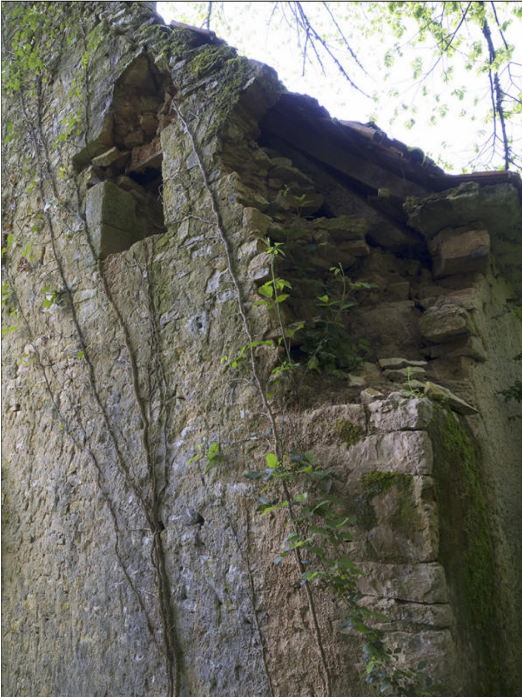
Fig. 13 - La maison : pignon Nord et détail des arrachements (chaînage d'angle et linteau de la fenêtre des combles).
