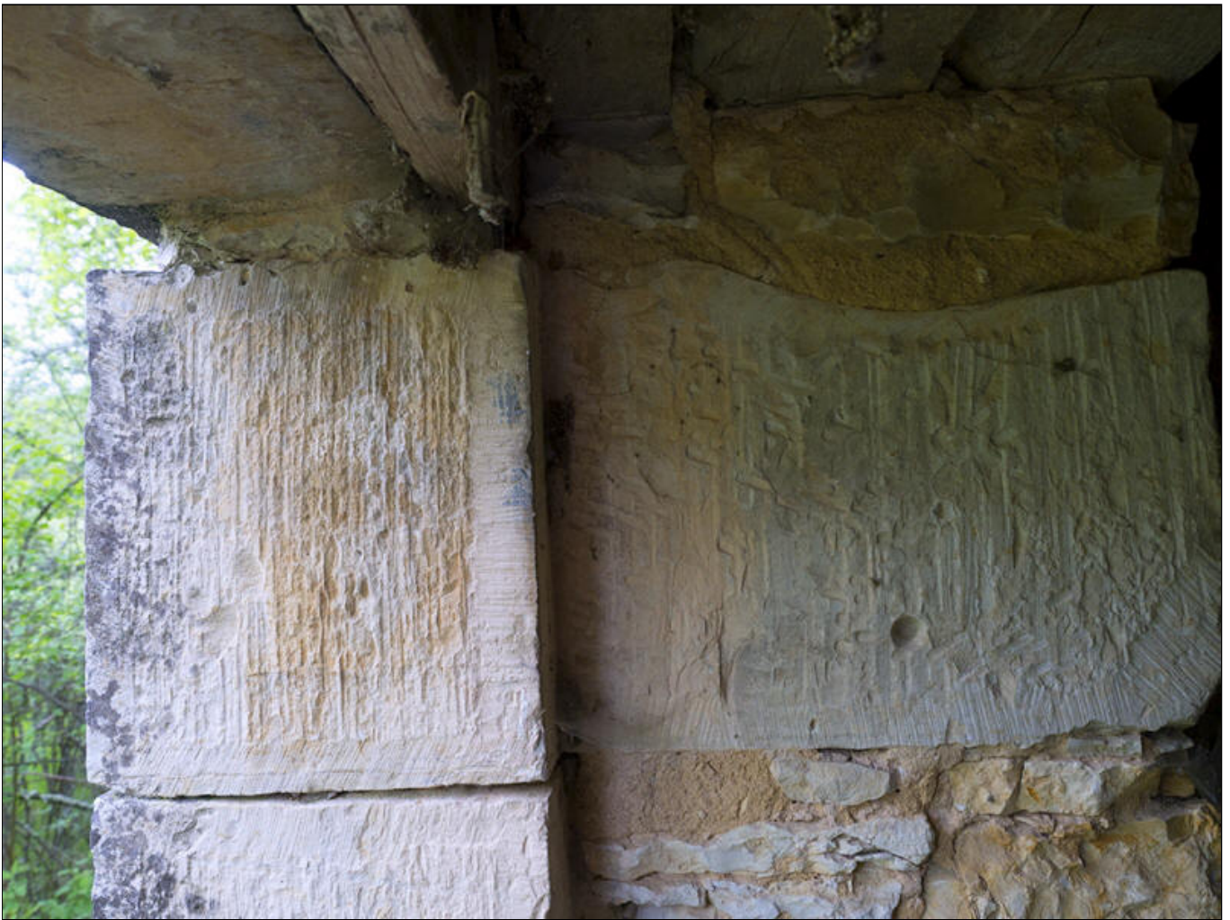
Fig. 45 - Le pigeonnier : angle de l'entrée Ouest.
