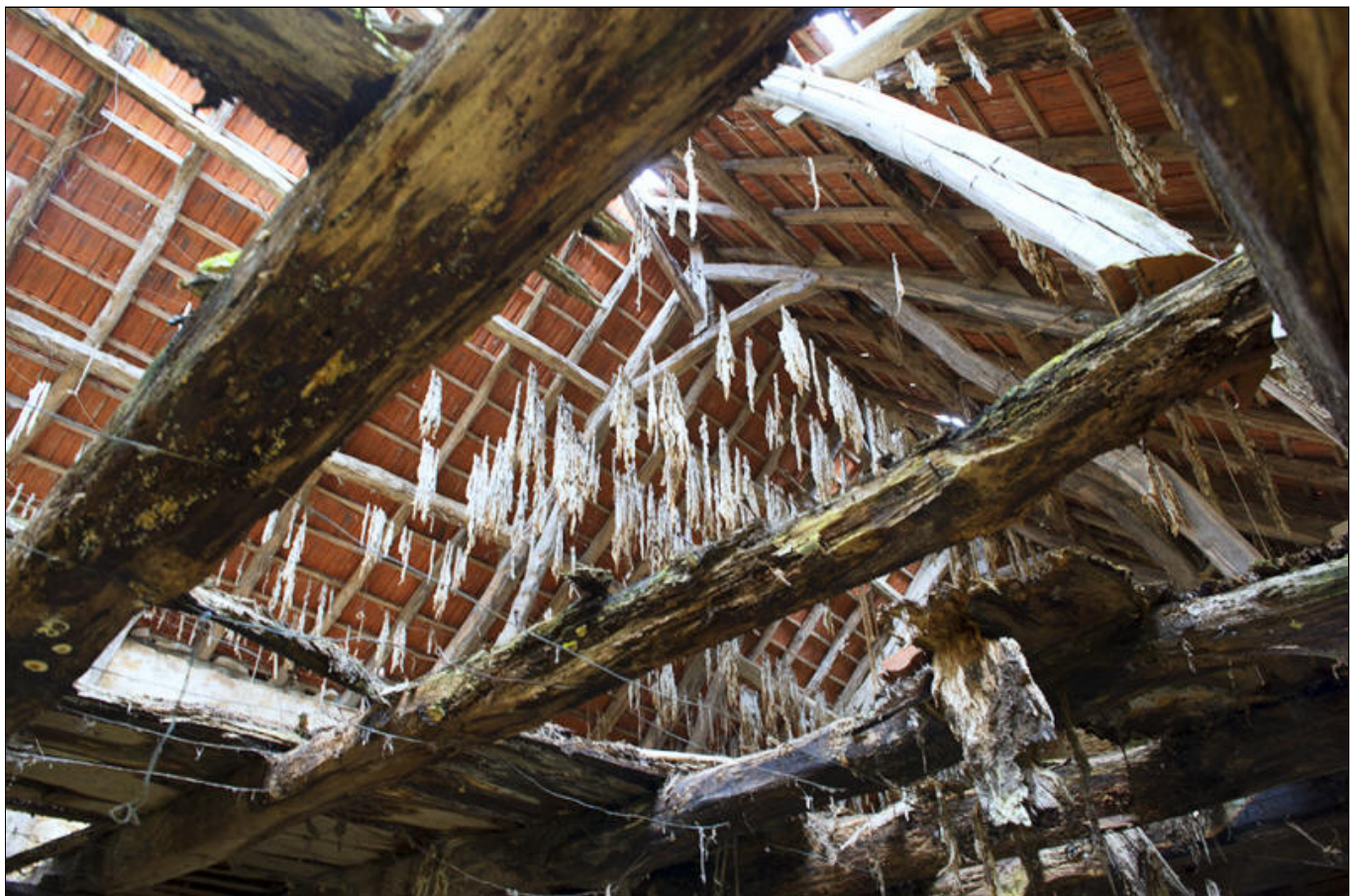
Fig. 36 - Grange N° 2 : restes de tabac séché pendu sous la toiture.
