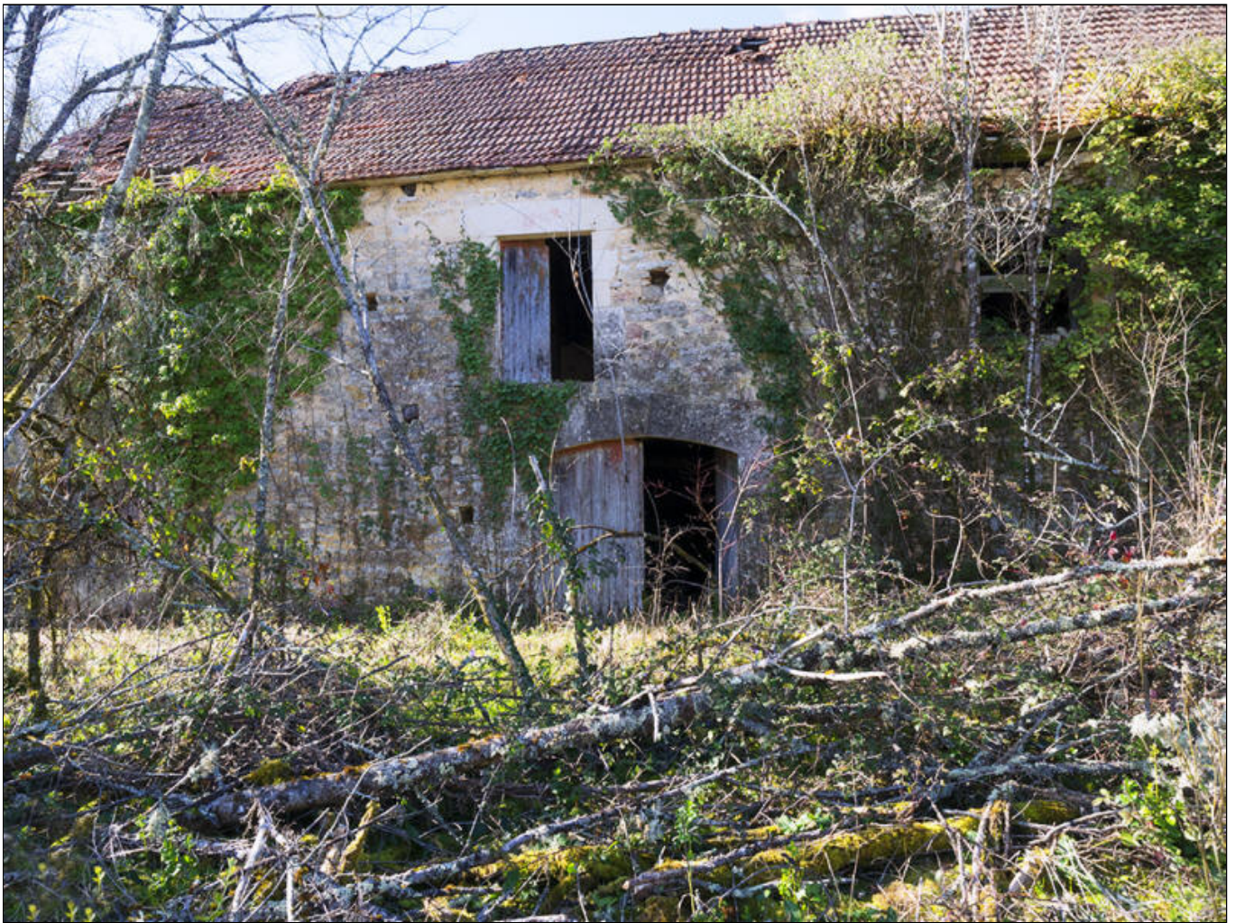
Fig. 33 - Grange N° 2 : la porte centrale et la fenêtre qui la surmonte.
