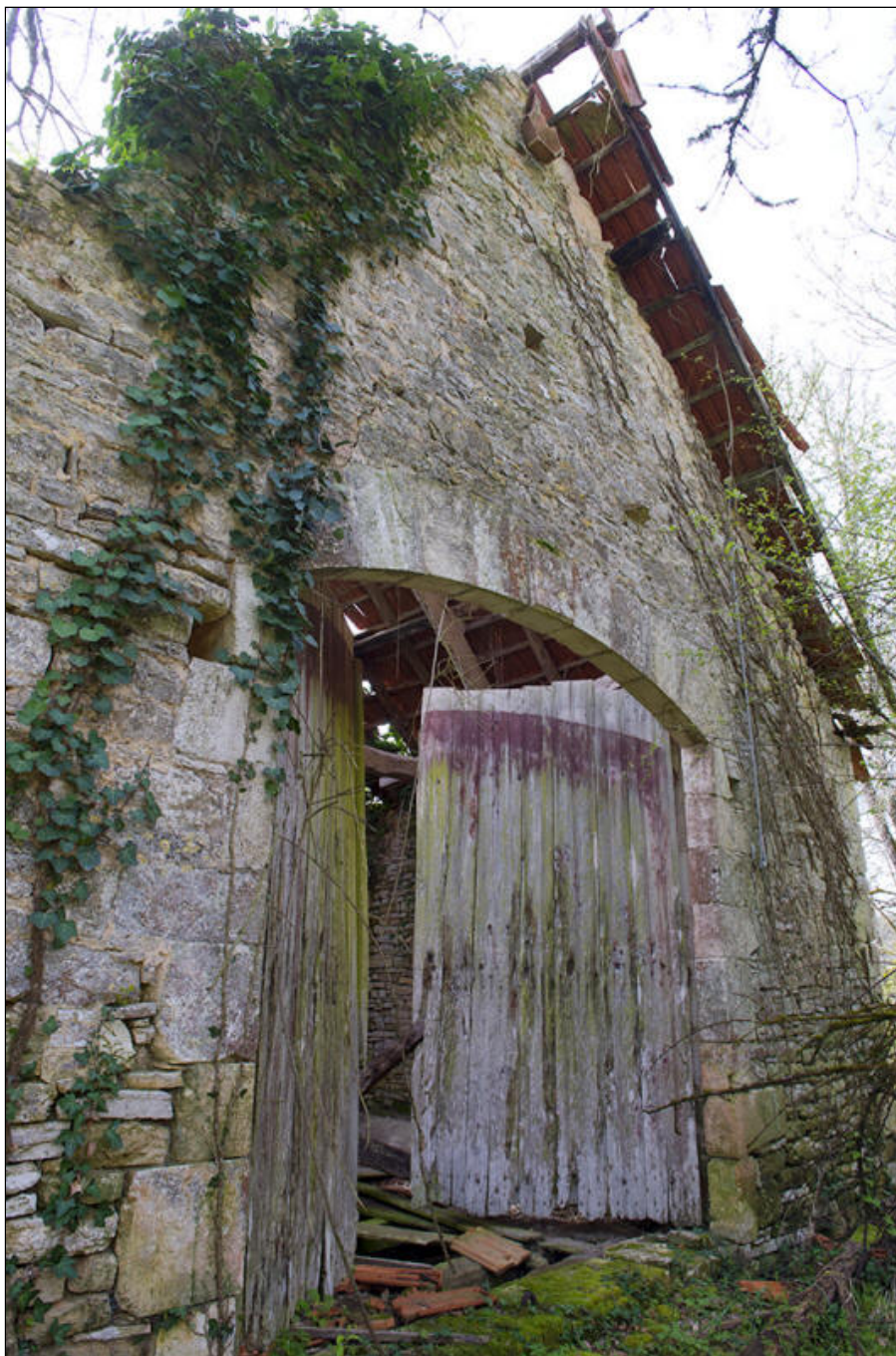
Fig. 28 - Grange N° 1 : pignon Ouest avec son entrée surmontée d'un arc surbaissé.
