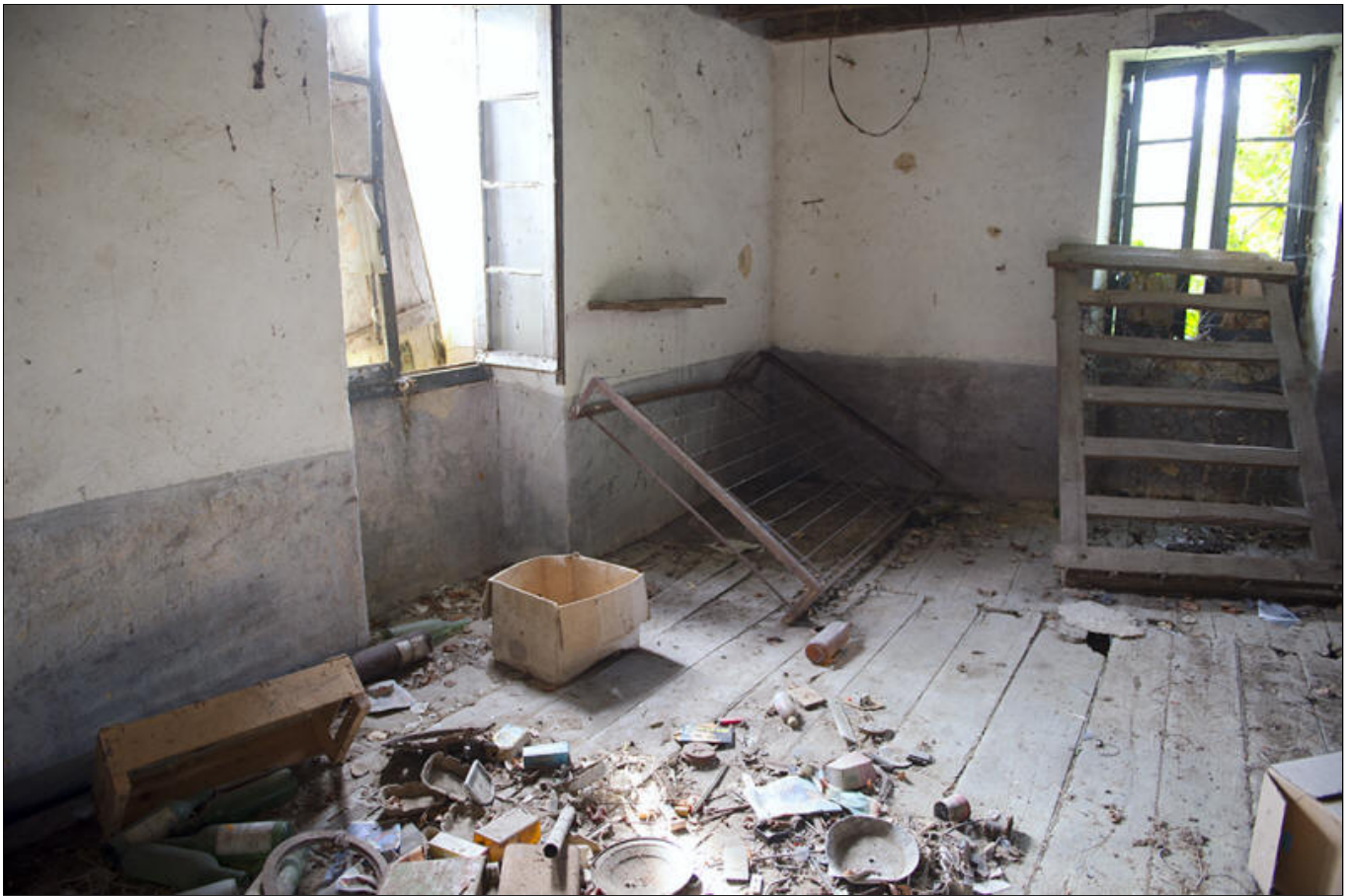
Fig. 19 - La maison : la chambre et la deuxième fenêtre de la façade Est.
