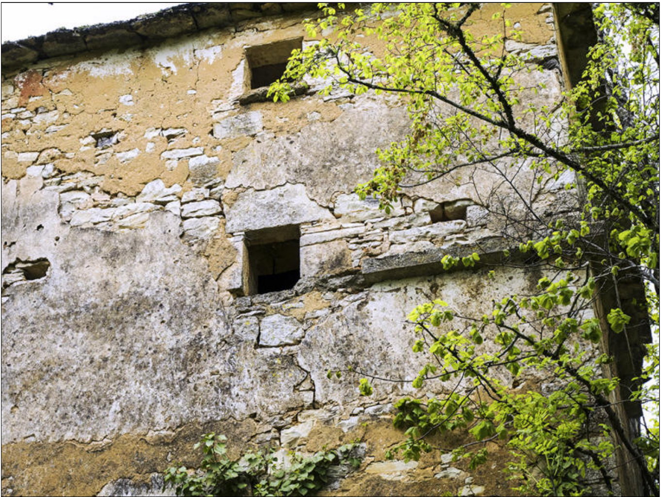
Fig. 41 - Le pigeonnier : lucarnes et randière en haut de la façade Est.
