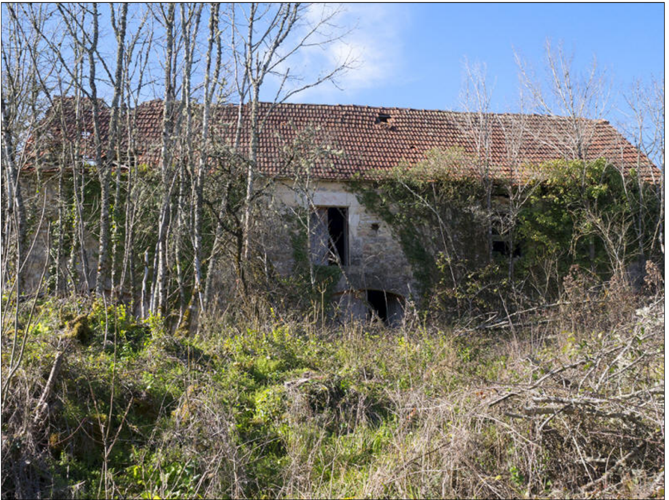
Fig. 32 - Grange N° 2 : façade Est.
