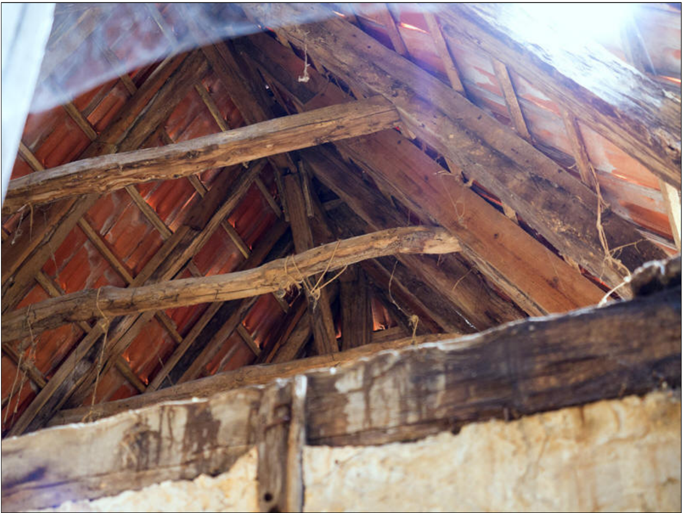
Fig. 15 - La maison : les combles en contre-plongée.
