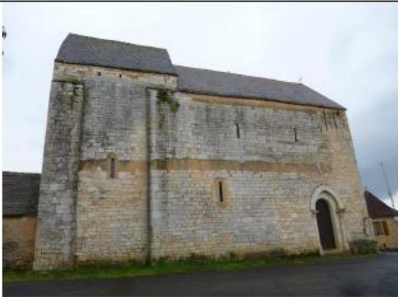
Façade nord avec trace d'un premier niveau de construction de la nef et un portail « réinventé » (?).
